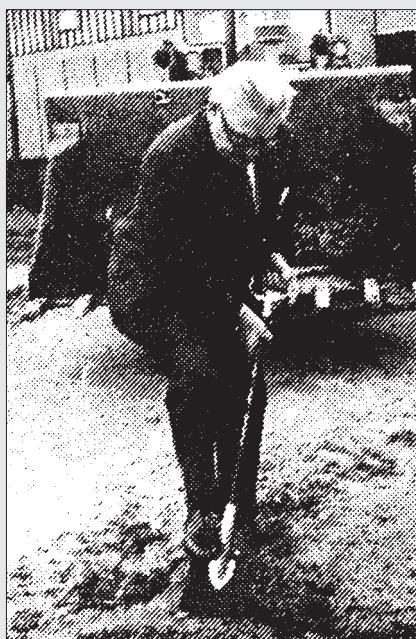
Første spadestik til annekshallen tages af borgmester A. Stæhr Johansen, hvorefter moderne maskiner tager fat 11. oktober 1976.
